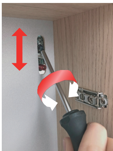
Fig. 3 | Réglage des supports d'armoire
